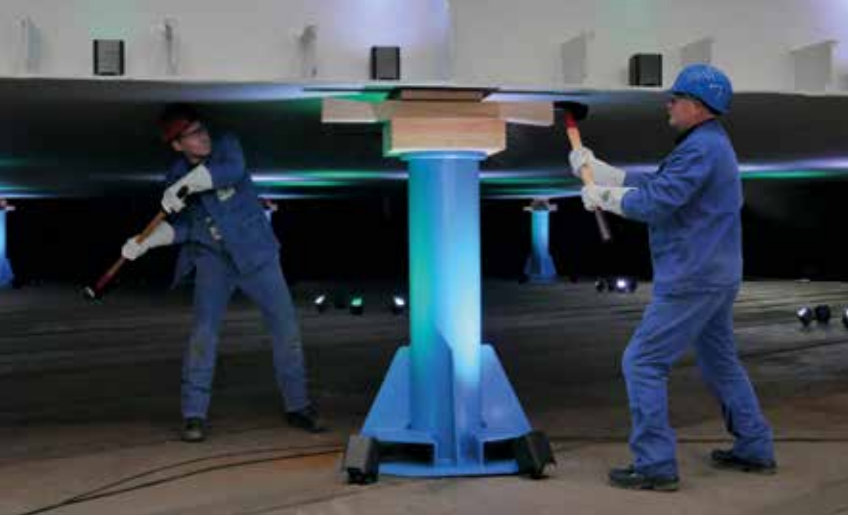
Die Kiellegungsplatte wurde mit Keilen unter den Kiel getrieben.
